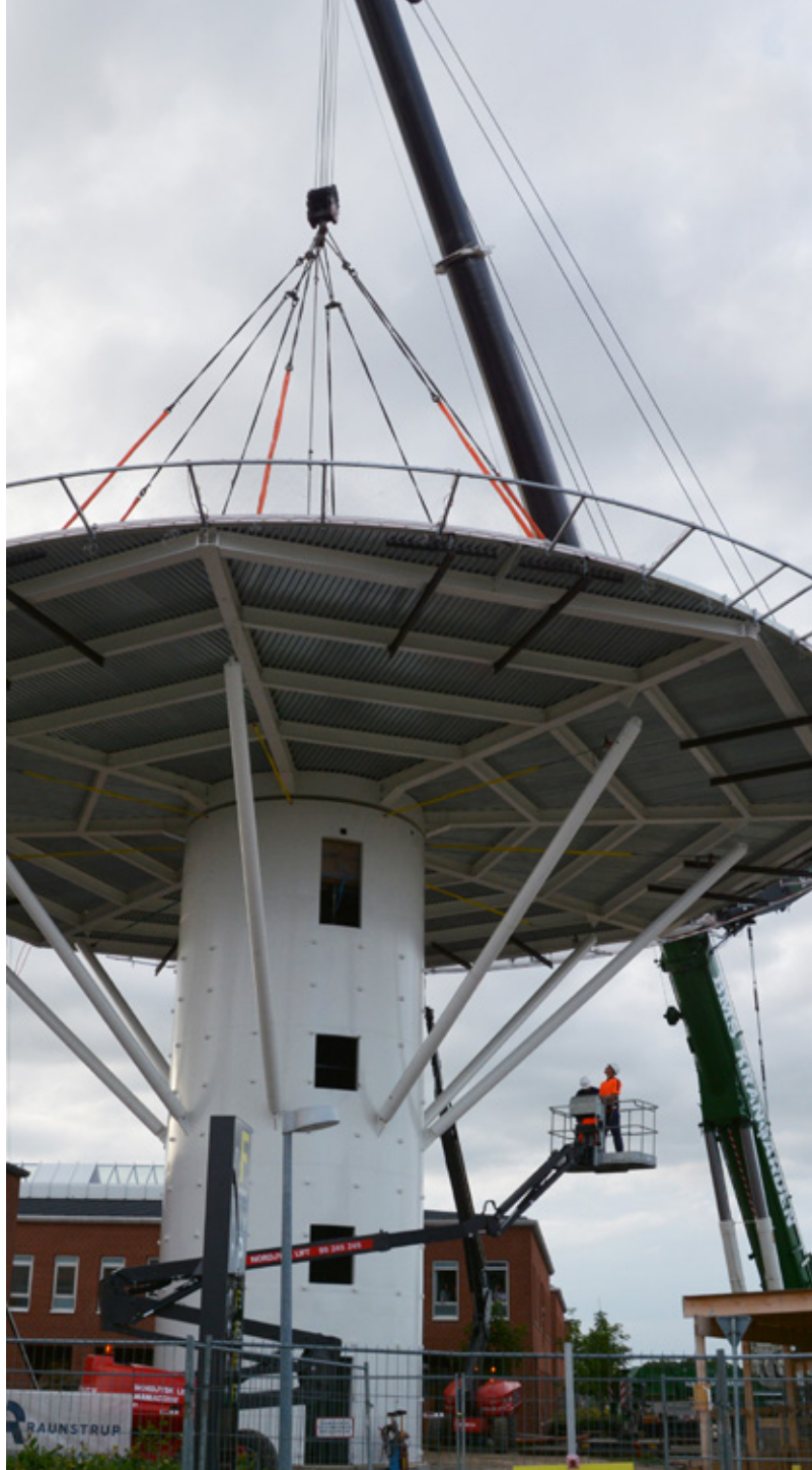
Montage af 70 ton tunge helikopterplatform til Skejby Sygehus.
