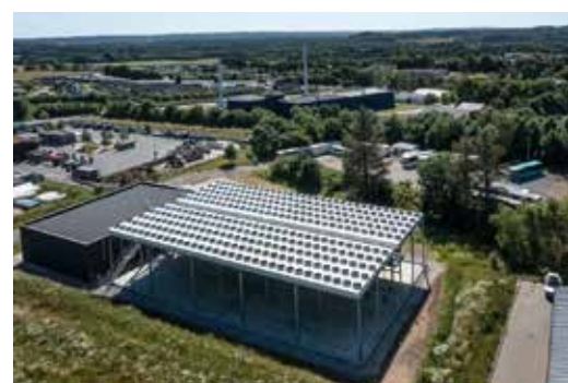
Ny nærliggende lokation med energioptagere og varmepumper
