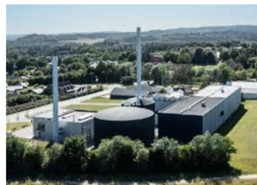
Det oprindelige Ry Varmeværk udvidet med akkumuleringstanke
