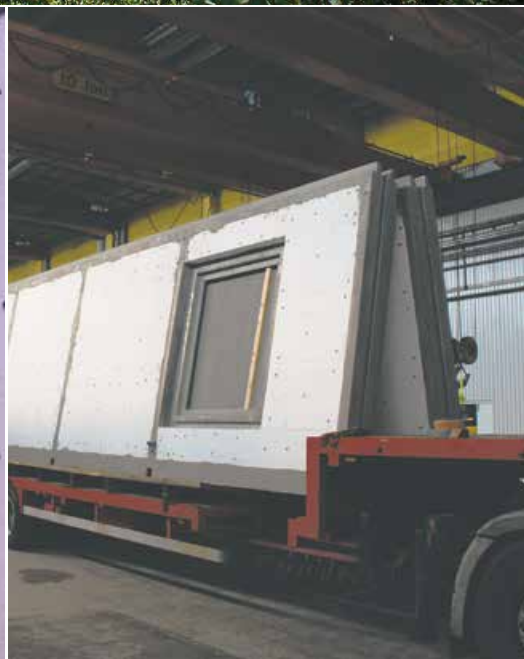
ENKELTSIDET FACADEELEMENT MED ISOLERING
