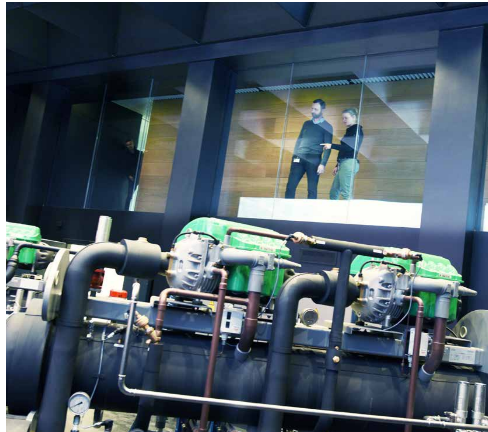
Danfoss Turbocor® kompressorer - de grønne på billedet - er blandt de Danfoss komponenter, der indgår i en varmepumpe.
