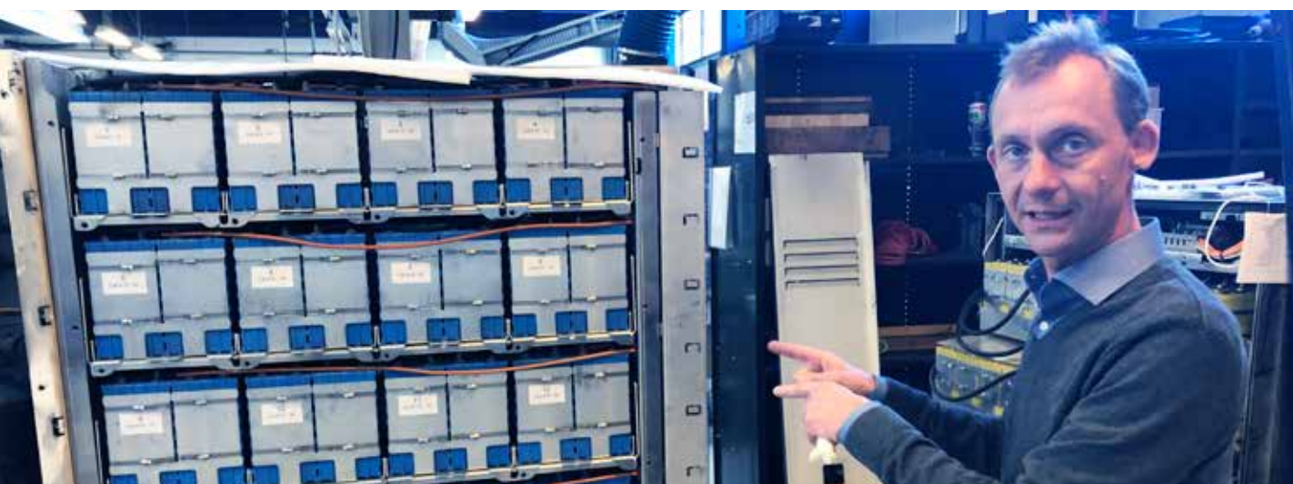
Direktør Rasmus Banke med en af de batteripakker, der gør skraldebilen støjsvag og energivenlig.
