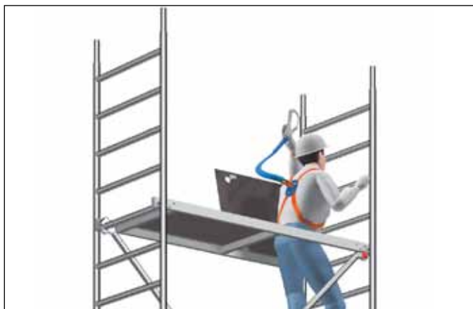
Fig. 1: Fastgørelse af faldsikringsudstyr under opstigning til det ikke-sikrede niveau Fig. 3: Sikker montage af rækværket ved brug af faldsikringsudstyr
