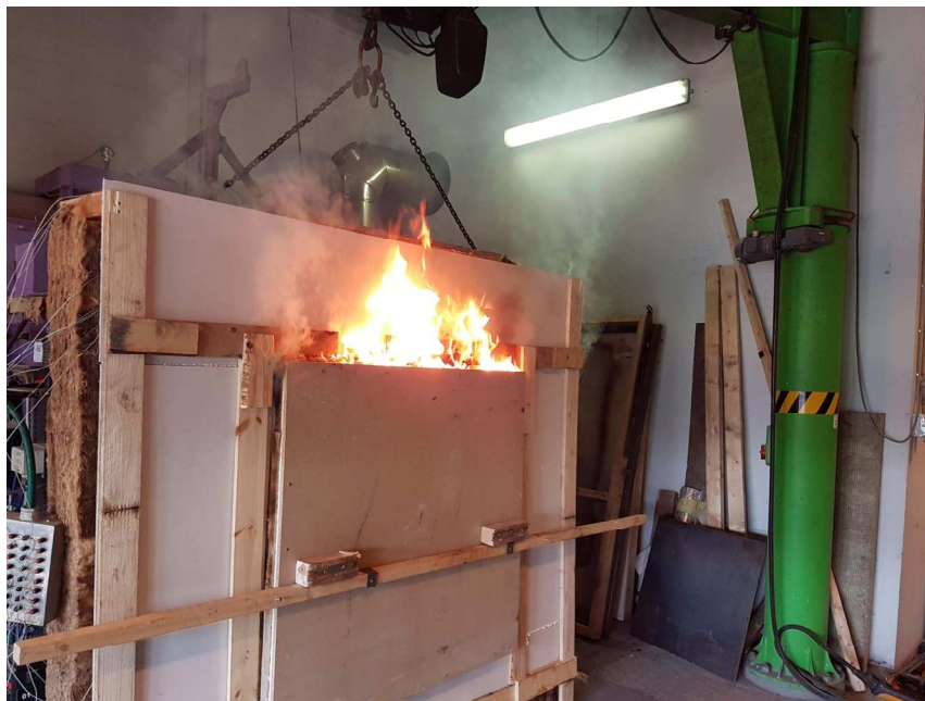
60 min. Synlige flammer fra brændende karmtræ fra vindue. Temp. under plade i top af test element 90°. Kriterier for godkendt er under 180°
