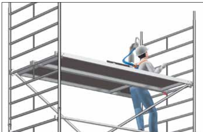
Fig. 1: Fastgørelse af faldsikringsudstyr under opstigning til det ikke-sikrede niveau
