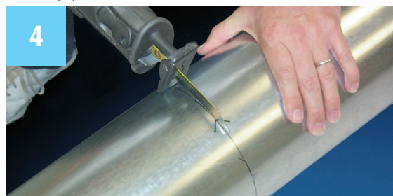
Sav røret over.
