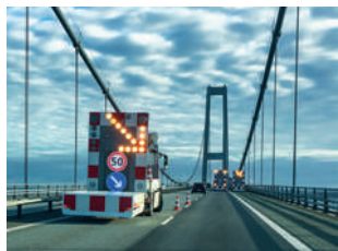
TMA med LED-tavle opstillet på Storebæltsbroen
