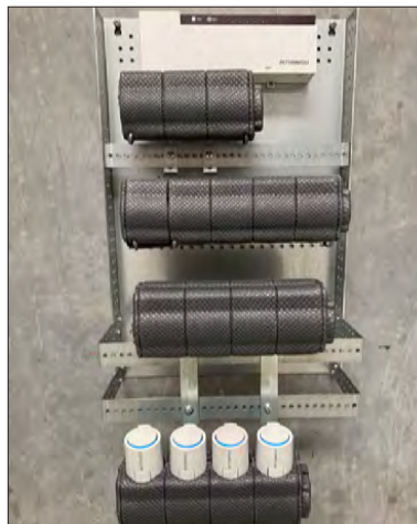
Skaktløsning med ekstra tilbehør: gulvvarmestyring og telestater.
