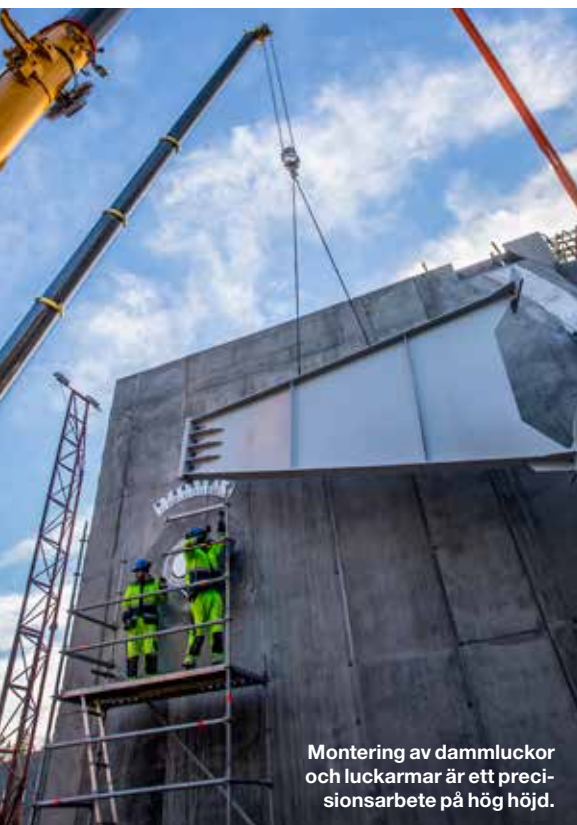
De välvda luckorna i rostfritt stål lyfts på plats
