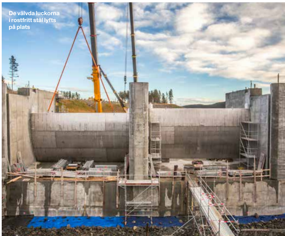
Montering av dammluckor och luckarmar är ett precisionsarbete på hög höjd.
