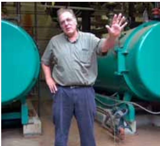
Charlie Howland, ejer af fabrikken Warwick Mills, foran fabrikkens biomasseanlæg. Warwick Mills har en 2 MW Dall Energy ovn til at forsyne virksomheden med damp. NO x : 80 mg/Nm 3 . Støv: 10 mg/Nm 3
