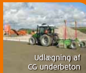
Produktion af CG underbeton
