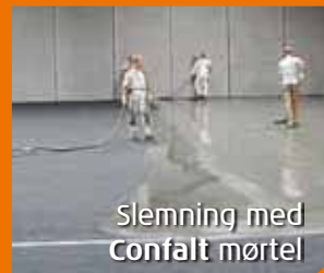
Udlægning af CG underbeton
