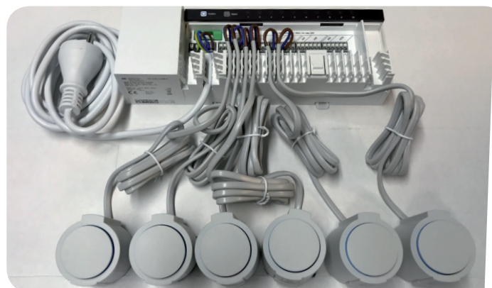
Eksempel: 10 kreds styreboks med 6 telestater
