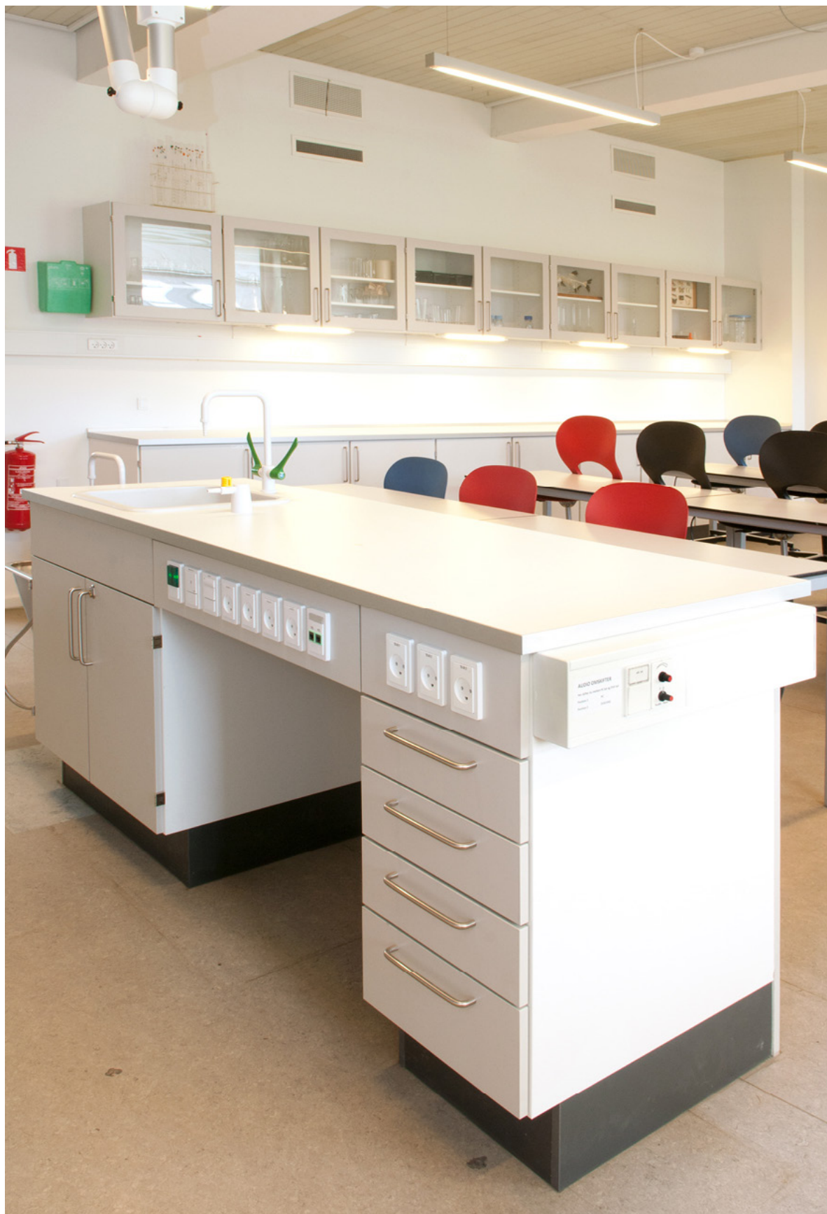
LÆREBORD med alle de nødvendige installationer som el og gas, samt laboratorie vask og armaturer
