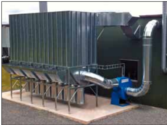
Det nyudviklede filter type APF-XL Volume leveret til en svensk køkkenproducent, kapacitet 45.000 m 3 /h.
