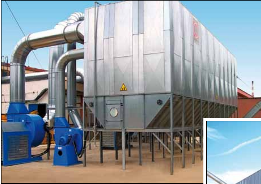
Filteranlæg type AKF-WDXK for henholdsvis møbelfabrik i Kleipeda i Litauen og limtræsfabrik hos Swedwood i Tikhvin Rusland.
