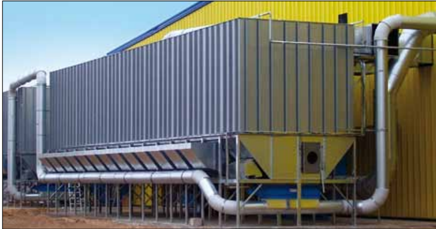
Filter AKF-WDAK med ATEX eksplosionsklapper installeret i Hviderusland for 250.000 m 3 /h.
