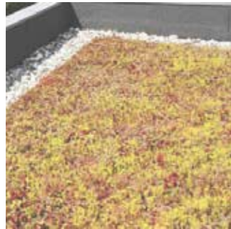
FLADE TAGE MED SEDUM
