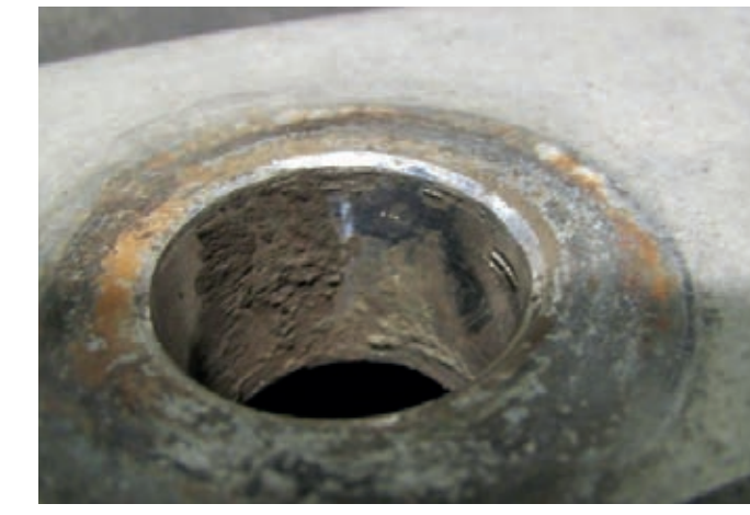
Korrosion ved hjulbolt
