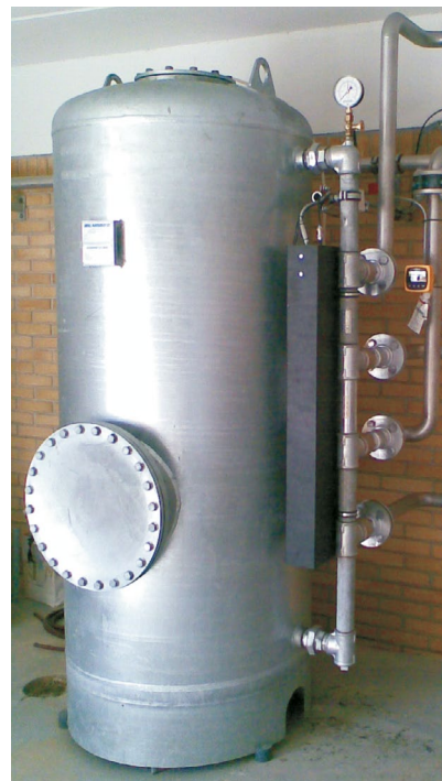
Arsenjernfjernelse ved adsorption på vandværk i Østjylland. Løsningen består af automatisk trykfilteranlæg NSB 170, som er installeret efter åbne filtre. Ydelsen er 12 m 3 /h.
