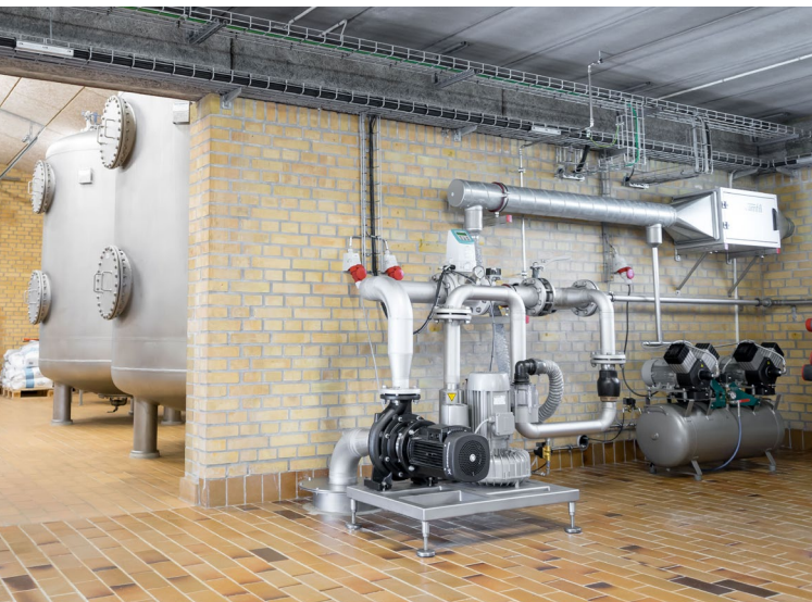
En komplet vandbehandlingsløsning består foruden trykfilter også af teknisk udstyr til iltning og returskyllning.
