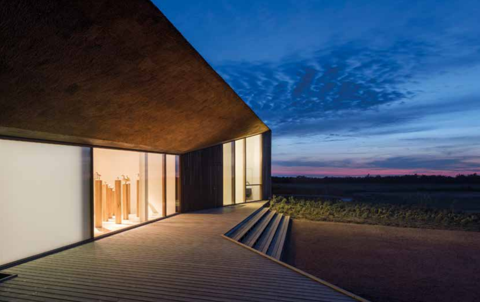
I hulrummet mellem tagkonstruktion og strå er der installeret termodektektering.
