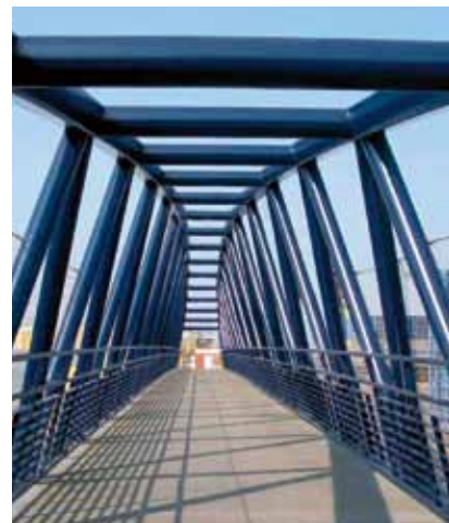
Cirkulära konstruktionsrör, River Tawe South Bridge i England. Bild från Corus.
