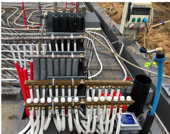
Skræddersyet BUNDMODUL med: 15 gulvvarme-, 11 koldtands- og 8 varmtvandskredse
