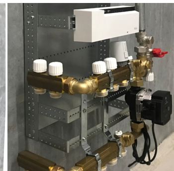
Max. bestykning af et BUNDMODUL for at det kan være i et 60 cm skab. 12 gulvvarme-, 16 koldtands- og 9 varmtvandskredse.
