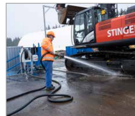
Nachwäsche im Ausfahrtsbereich Afterwashing in the exit area
