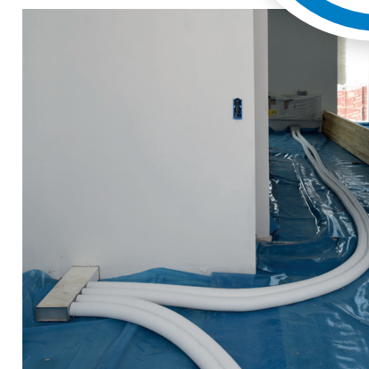
Slangerne udlægges for gulv etableres.
