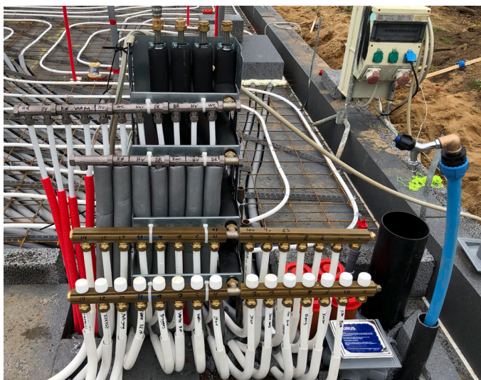
Skræddersyet BUNDMODUL med: 15 gulvvarme-, 11 koldtands- og 8 varmtandskredse
