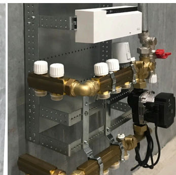
Max. bestykning af et BUNDMODUL for at det kan være i et 60 cm skab. 12 gulvvarme-, 16 koldtands- og 9 varmtandskredse.
