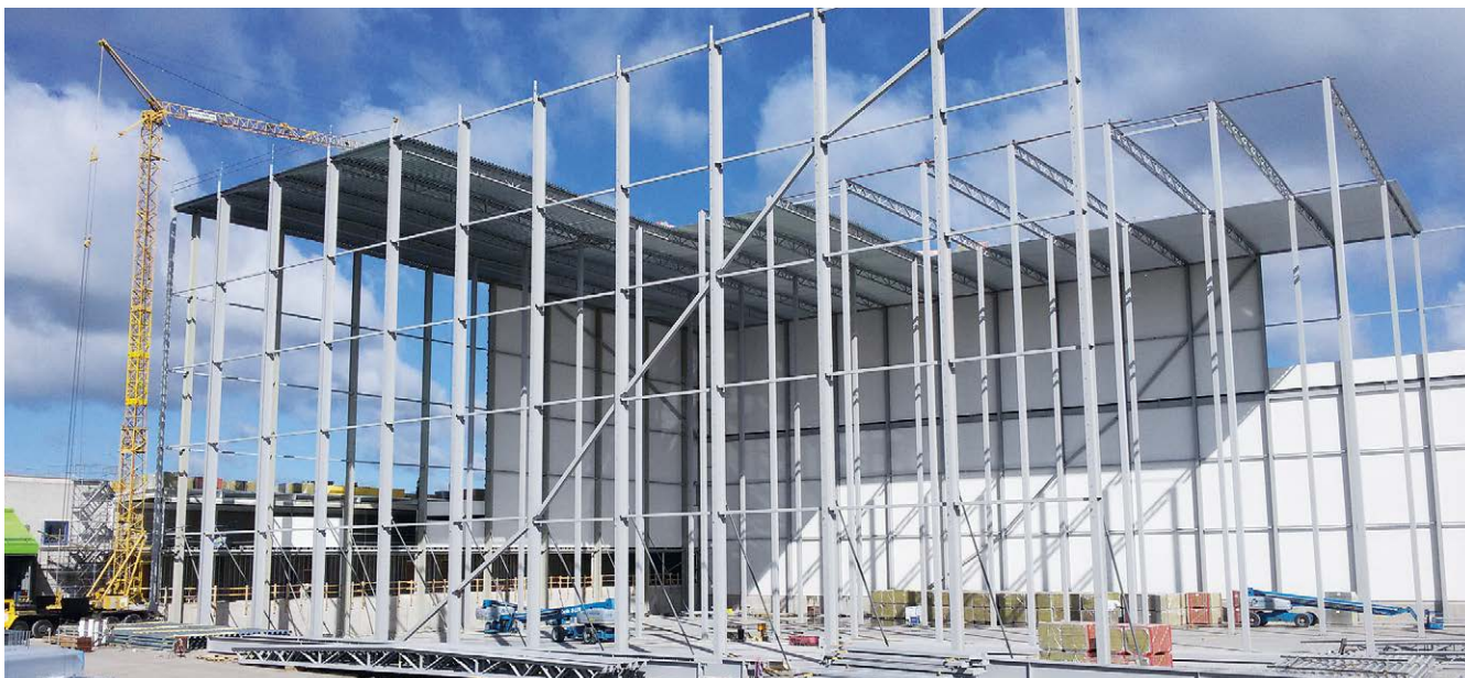
Montage av högprofilerad takplåt på fackverkstakstolar och sandwichpaneler mot pelare i hallbyggnad.
