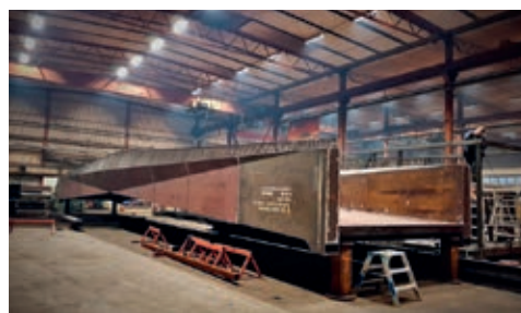
Bron står färdig i Stål & Rörmontages verkstad och väntar på målning.
