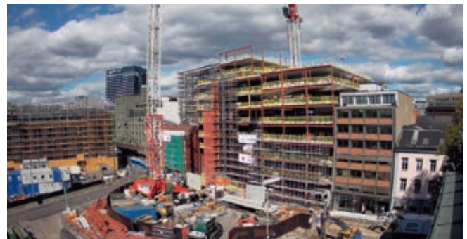
Byggingen av KA 13 og 15-17 foregår vegg i vegg med mange ulike aktører.
