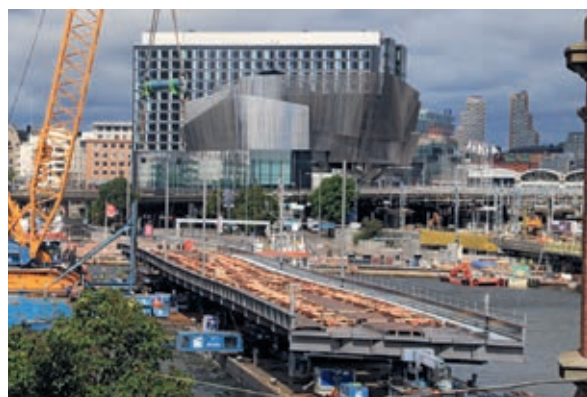
Den norra delen förbereds för att lyftas på plats.
