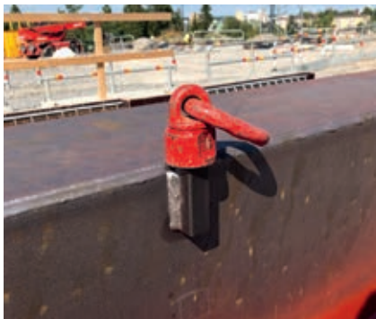
Bild 1. Lyften kan göras av två svetsbara långmuttrar som fästs på var sida om livet i balkens 1/5 dels punkter.
