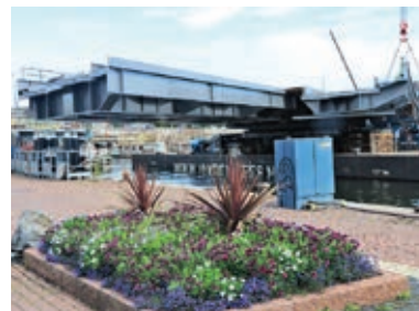
Norra delen ligger och väntar på att lyftas på plats.
