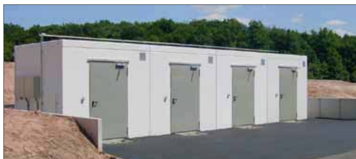
Containeranlæg til farlige stoffer med fire brandsektioner bestående af fire stk. individuelle DK 09
