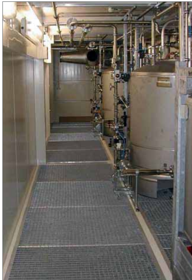
BCK brandsikker container med individuelt doseringsanlæg
