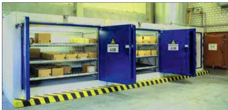
Brandsikret lager og opbevaring af sprængstoffer bestående af tre DK 04 containere til farlige stoffer, med reoler som specialudstyr.
