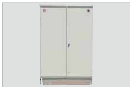
Udluftningsriller foroven og forneden i døren
