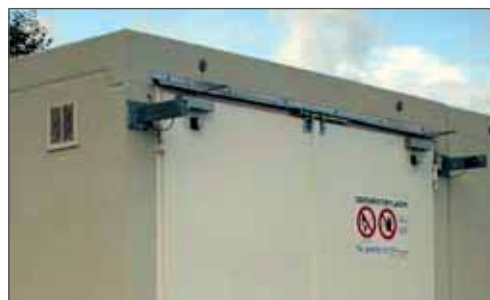
Branddørlukning, klimaanlæg med lukkerækkefølge-regulator
