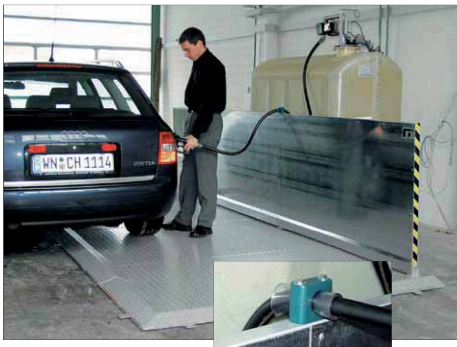
Sikker holder til påfyldningsslangen med knæbeskyttelse og længebegrænser
