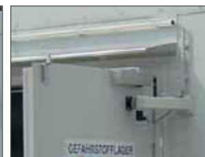
Branddørlukning med magnetisk holdearm, automatisk dørlukning ved brand
