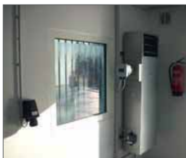
Ekspllosionssikret varmepumpe og G90 rude
