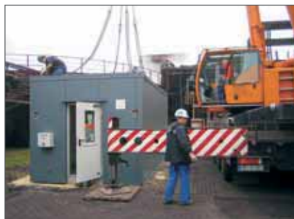
Montage af centralt udendørs opbevaringsrum til sikkerhedsteknik
