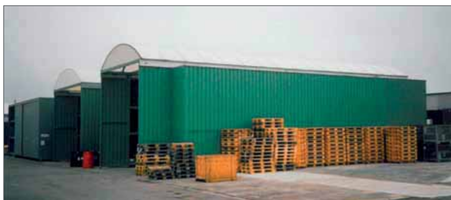
Tre lagerhaller bestående af reolcontainere à 15 m længde
