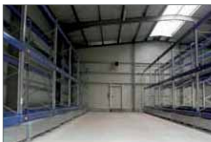
Isoleret lagerhal til frostfri opbevaring af vandforurenende stoffer i 216 IBC'ere
