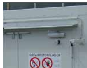
Branddørlukning med magnetisk holdearm, automatisk dørlukning ved brand
