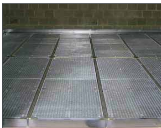
Individuelle stålelementer med krydsforbindelser og forbindelsesprofiler samlet på et lagerområde
