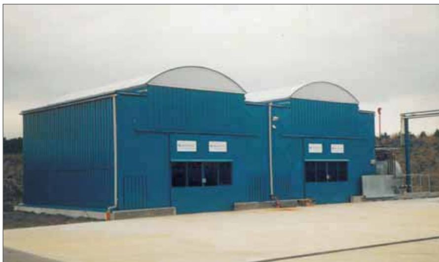
Lagerhal til opbevaring af farlige stoffer bestående af reolcontainere med tre hyldeniveauer
