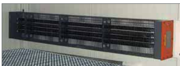
Varmeapparat med lameller
