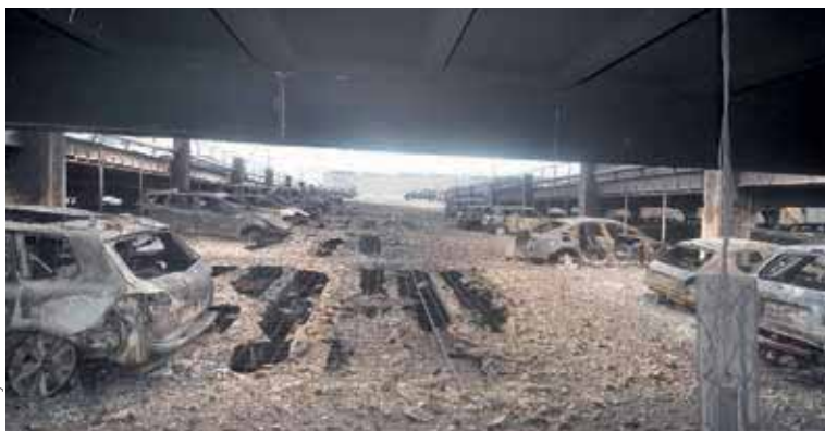
Leilighetene i høyblokkene rundt parkeringshuset hindret ventilasjon. Bildet til høyre viser den sterke betongavskallingen.
