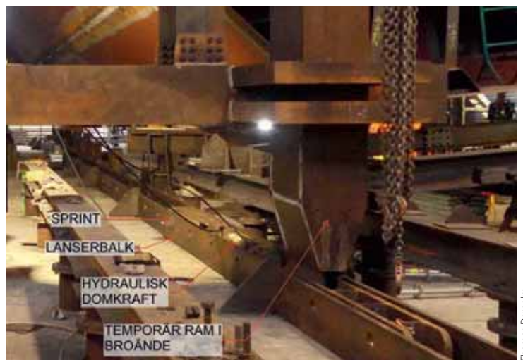
Figur 8. lanseranordning och domkraft
