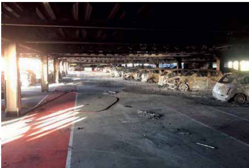
Denne ubeskyttede stålkonstruksjonen kollapset ikke, selv etter alvorlig brann.
