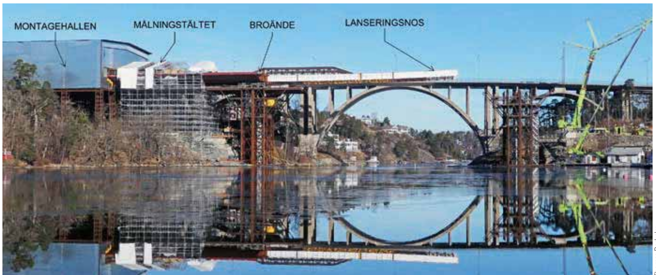
Figur 6. Visar montagehall, målningstält, brobalk och lanseringsnos.
