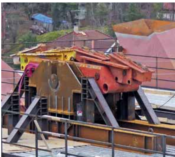
Figur 7. Lanserstöd vid pelare 4.
