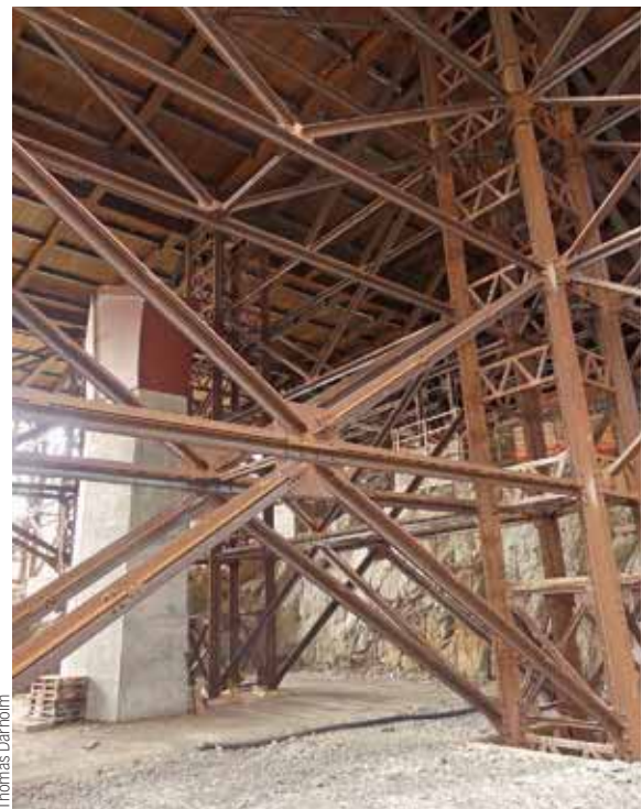
Figur 5. Den temporära fackverkskonstruktionen som bär upp montagehallen sedd underifrån samt pelarstöd 2.
