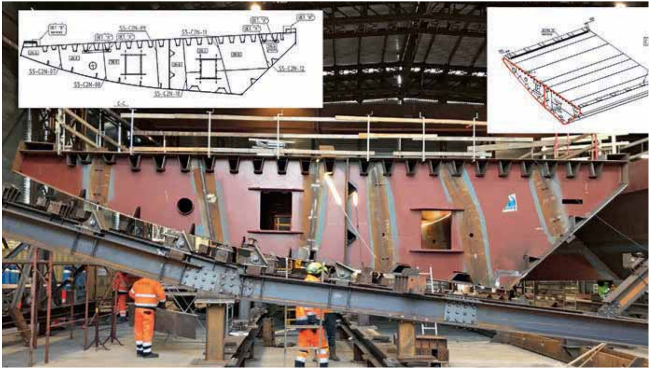
Figur 4. Brosektionens sju delar monteras ihop inuti montagehallen.
