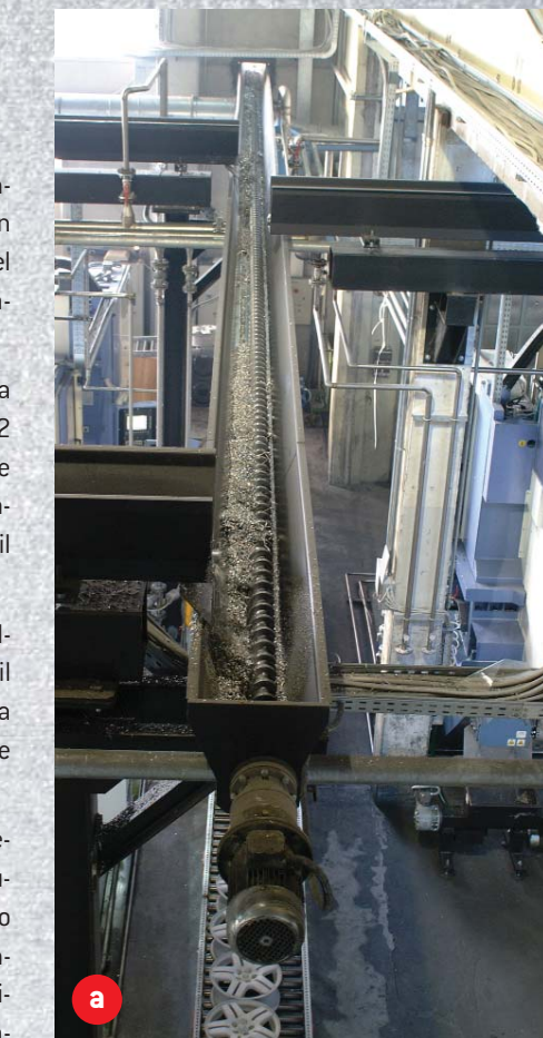
a. Rete di collettori aerei Overhead screw net conveyor
