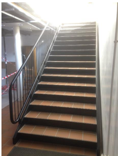
Billede 9: Ståltrappe - Præstø Svømmehal / Idrætshøjskolen Bosei.
