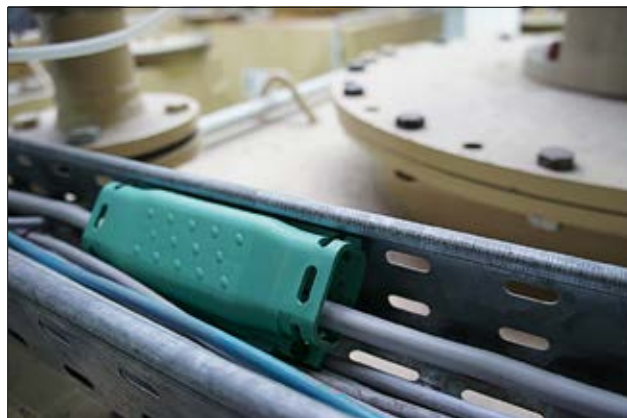
Gel kabelmuffe Relifix V til kabelreparation.
