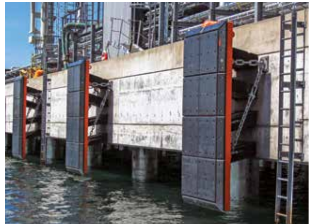
Ethanol Jetty | Stenungsund | Sweden
