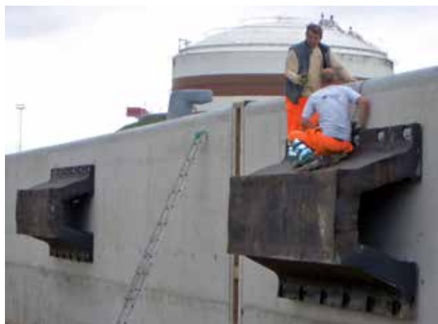
Toyotakaai | Zeebrugge | Belgium
