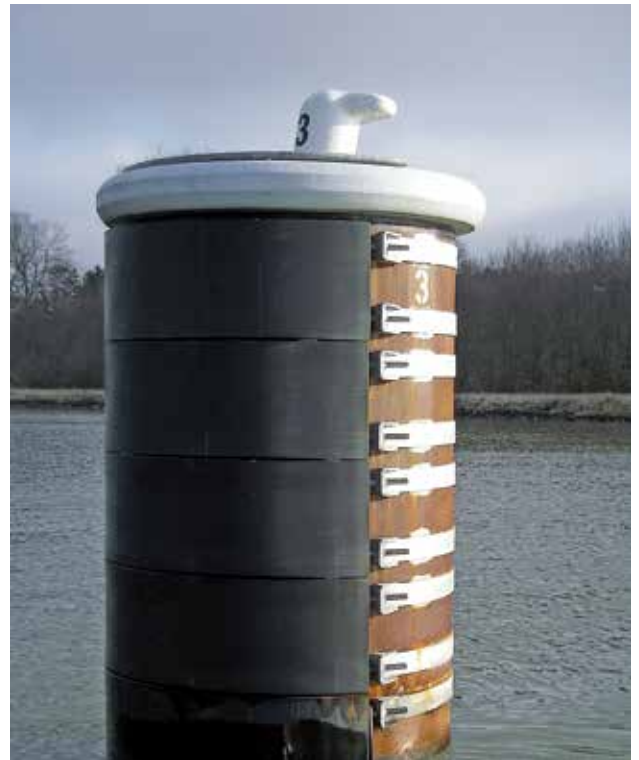
Standby piles | Kiel | Germany
