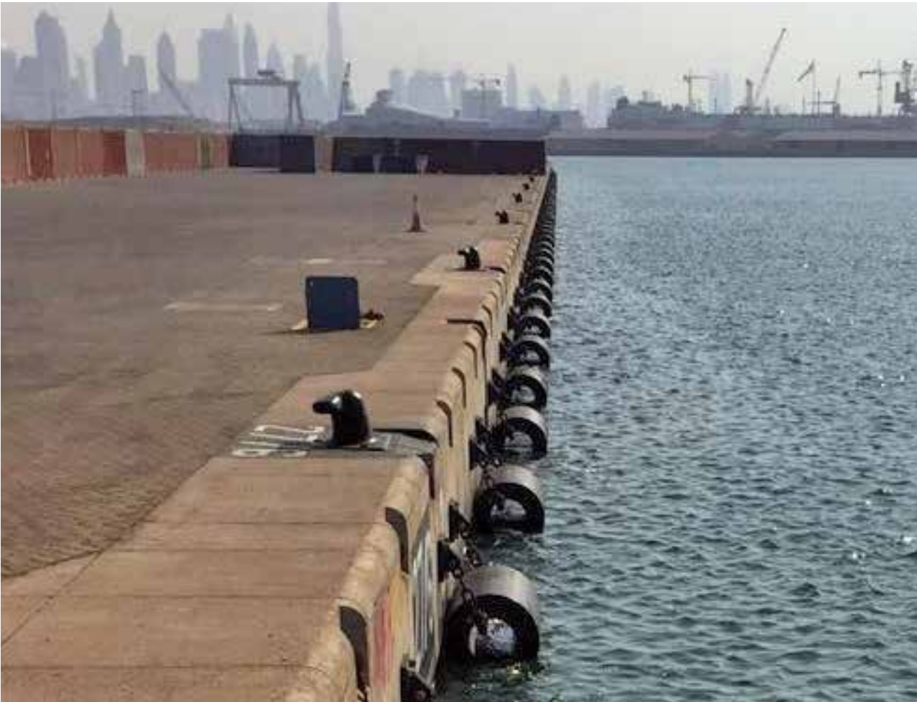
Rashid Port Berth 25 | Dubai | U.A.E.
