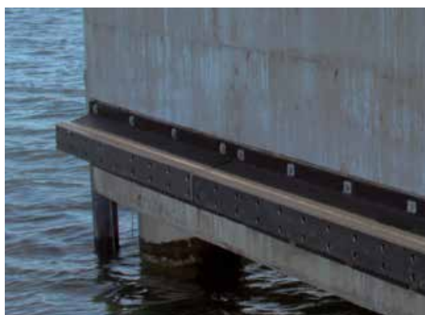
Ethanol Jetty | Stenungsund | Sweden
