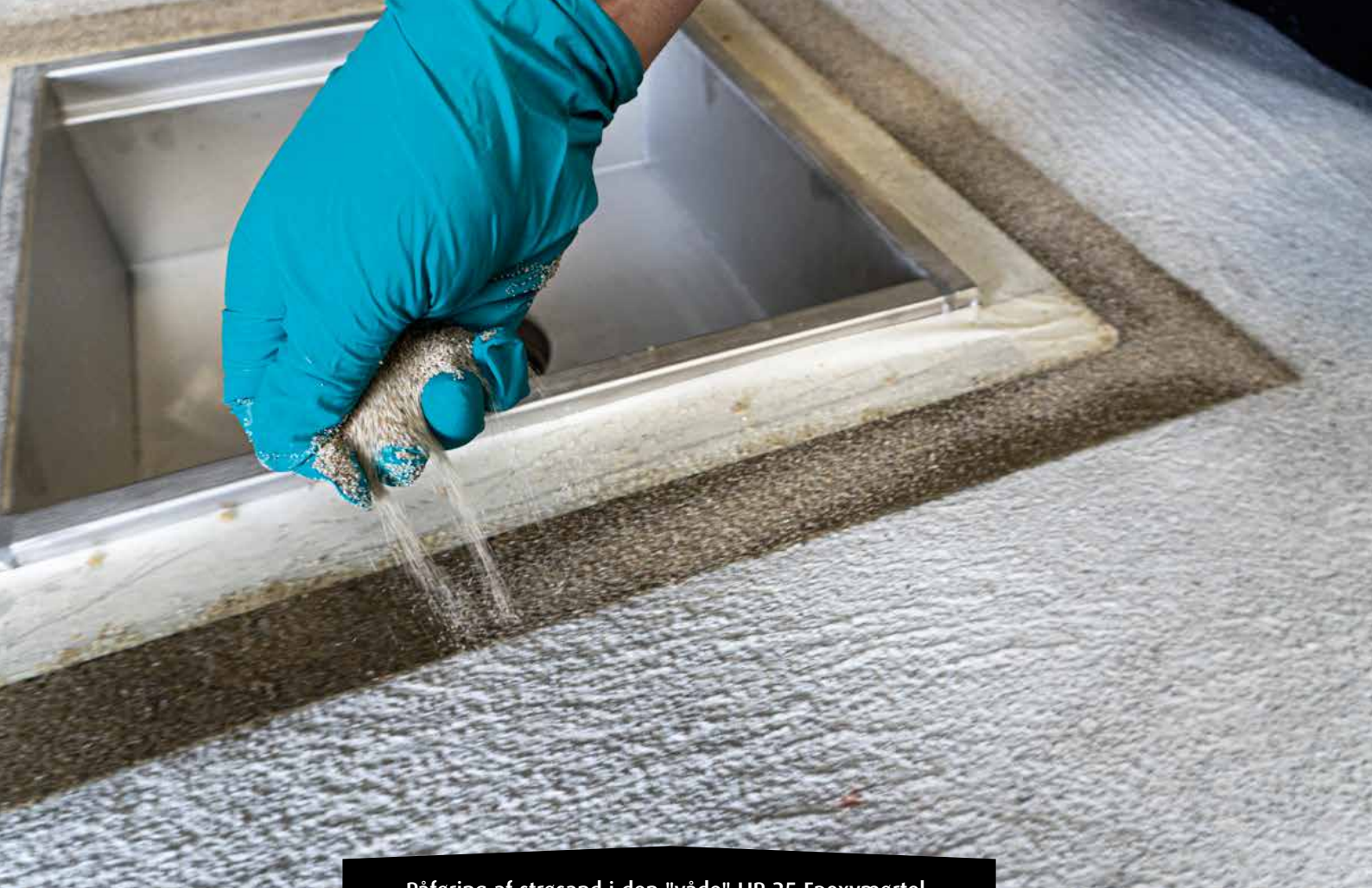
Påføring af strøsand i den "våde" LIP 25 Epoxymørtel.
