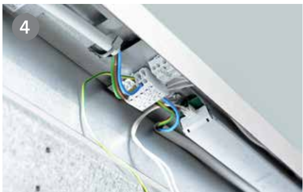
4 Ledningen sluttes til en 5-polet klemme med gennemfortrødning.
