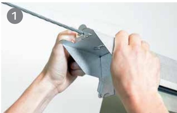
1 Armaturet monteres på wiren og sikres med et integreret beslag.
