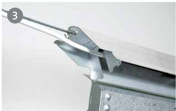
3 Ledningen trækkes gennem en slidsåbning i ydergavlen og sikres med kabelholderen.
