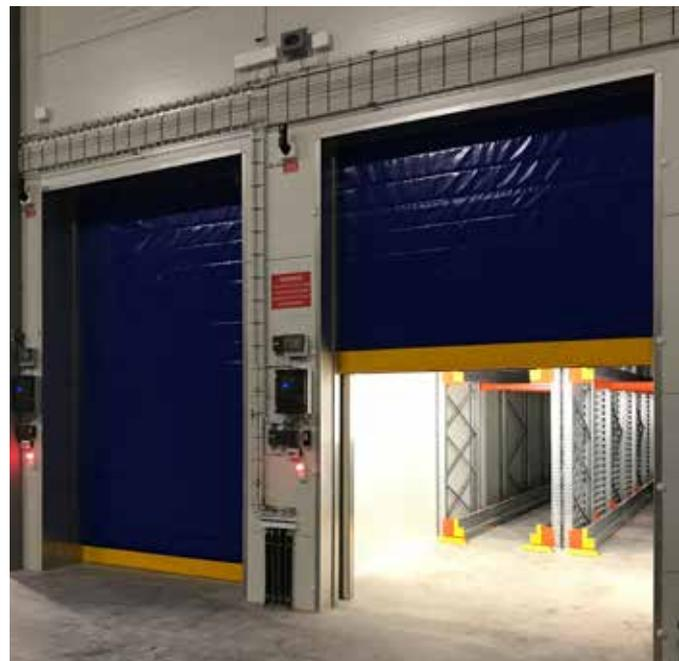
Das automatische vertikale Rollltor AVR0801F für Gefrierräume bietet eine äußerst moderne Lösung, die dank ihrer Konstruktion und ihres schnellsten Ansprechverhaltens für Kunden maßgeschneidert ist, deren Gefrierraum frequent mit Gabelstaplern befahren wird.
