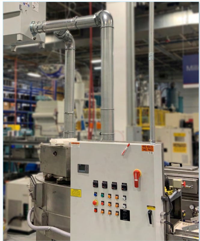
QFS rörsystem installerat
