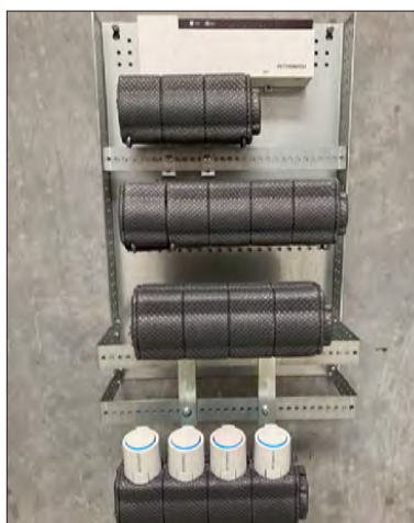
Skaktløsning med ekstra tilbehør: gulvvarmestyring og telestater.
