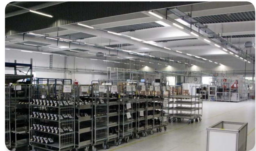
KE-Inject tekstilkanaler med huller til styring af strømningsforløb
