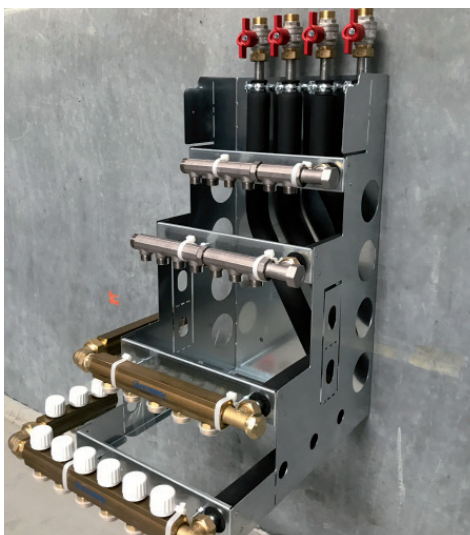
BUNDMODUL med 9 kredse gulvvarme, vinklet for at kunne være i skab. 7 varme og 6 kolde kredse brugsvand.
