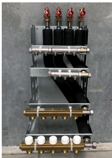
BUNDMODUL med 5 kredse gulvvarme, 3 varme og 5 kolde kredse brugsvand.
