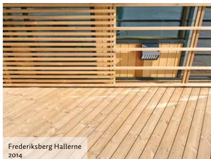
ThermoWood Profil 431 1x5" 21 x 118 mm Høvlet forside
