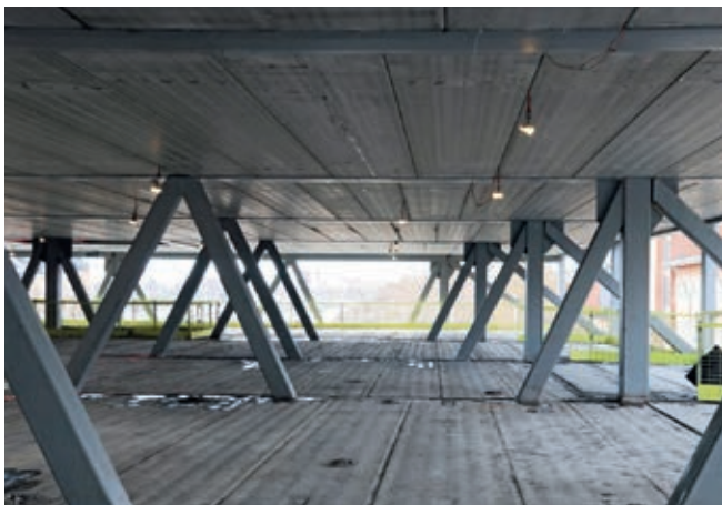
Fackverken placering har anpassats för att följa den böjda lastlinjen ner på tunnelväggarna.
