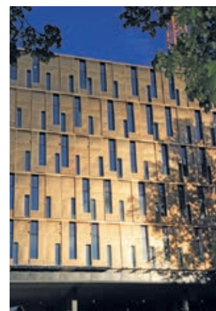
Fasadelementen prefabriceras och levereras av KG Construction, med en infärgad rostfri stålplåt (Rimex) från FMH Stainless. Fasaden är designad och projekterad av Gatun Arkitekter.
