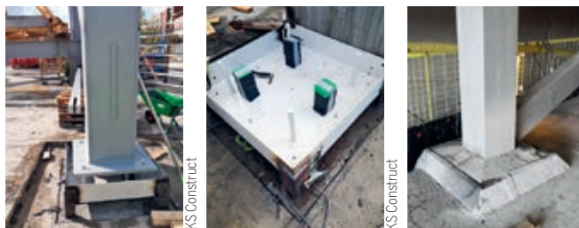
Hela byggnaden står på tunnelrören med friktion. Pelarfötterna förankras genom att de står i specialgjorda plåtlådor som är placerade ovanpå gummidukar. Ingjutningsgodsen i kontraforerna ställs också på gummiduk innan de gjuts in.
