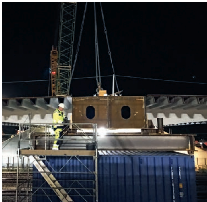
Plassering av brodekk på mellomstøtte.
