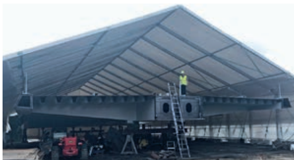
Broelementene ble sveiset sammen i et telt.
