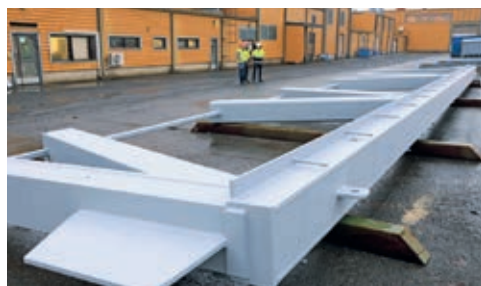
Fackverkens svetsades samman till två halvor i verkstaden och målades färdiga i Peräseinejoki och transporterades sedan med bil och färja till byggsplatsen i Stockholm.
