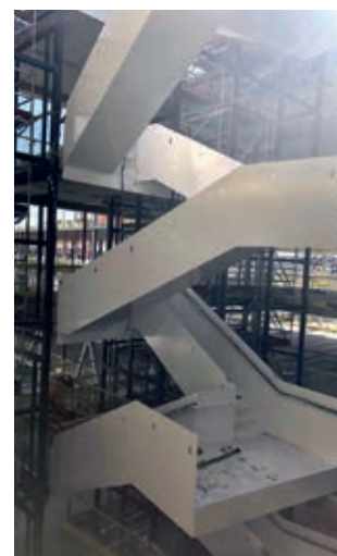
Två sickackformade ståltrappor från CSK kommer att monteras i atriumet. Stabiliserade ståltrappor med plåtsidor.
