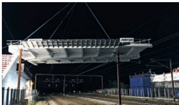
Innløfting av broseksjonens nordlige halvdel.
