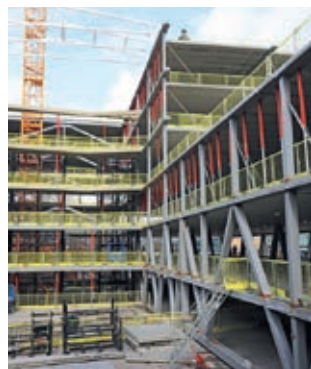
Ovanpå tvåplansfackverkens byggs sedan en pelare/hattbalkstomme med håldäcksbjälklag.
