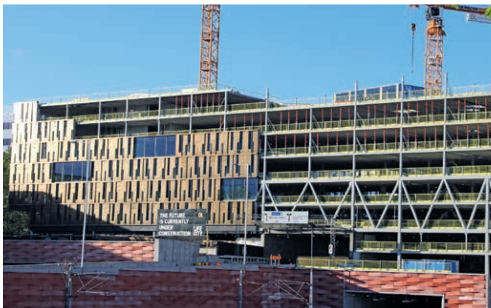
Fasadelementen prefabriceras och levereras av KG Construction, med en infärgad rostfri stålplåt (Rimex) från FMH Stainless. Fasaden är designad och projekterad av Gatun Arkitekter.
