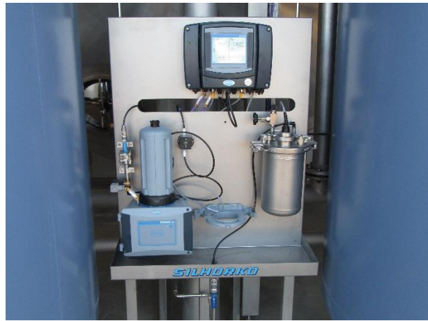
Monitering af vandkvalitet. Analysepanel til online måling af turbiditet og ilt.
