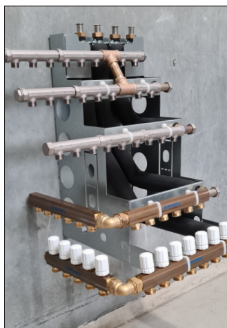
Max. bestykning af et BUNDMODUL for at det kan være i et 60 cm skab. 12 gulvvarme-, 16 koldtvars- og 9 varmtvandskredse.
