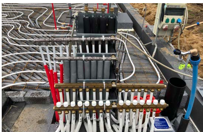
BUNDMODUL med: 15 gulvvarme-, 11 koldtands- og 8 varmtvandskredse
