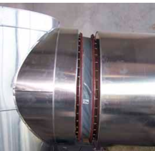
EKSPANSIONSBÆLGE MONTERET PÅ EKSISTERENDE ANLÆG: HHV. FORBRÆNDING, KRAFT/VARMEVÆRK OG SKIB
