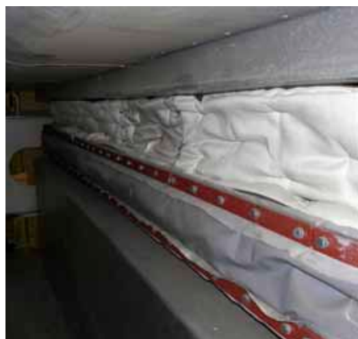
EKSPANSIONSBÆLGE MONTERET PÅ EKSISTERENDE ANLÆG: HHV. FORBRÆNDING, KRAFT/VARMEVÆRK OG SKIB
