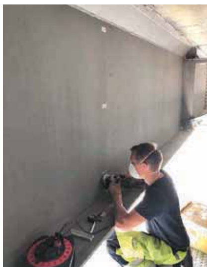
Figur 6. Instrumentering av brua for lastforsøk, påliming av tøyningsmålere.
