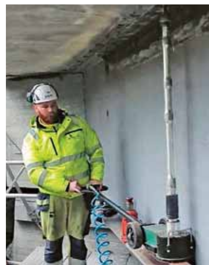
Figur 7. Installasjon av en coiled pinne.
