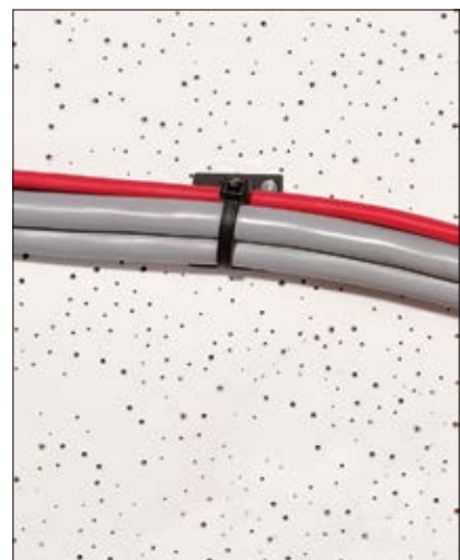
3. Når installation er klar strammes binderen til og overskydende materiale afklippes med montageværktøj.
