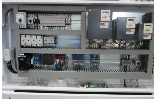
Quadro elettrico Electrical box Tableau électrique
