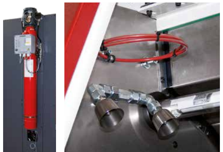
Système anti-incendie SIEMENS Feuerlöschanlage SIEMENS Fire extinguishing system SIEMENS
