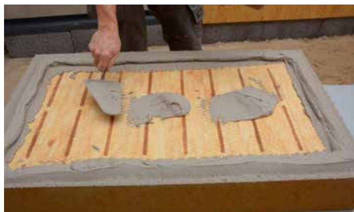
Påføring af facadeklæber med spandske
