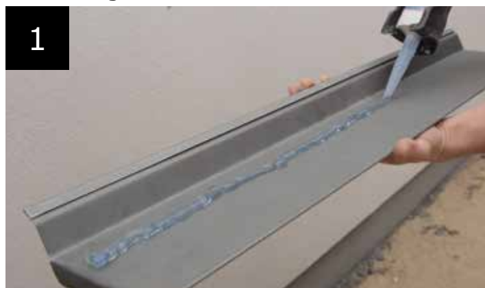
Påføring af Alfix M-Silicon
