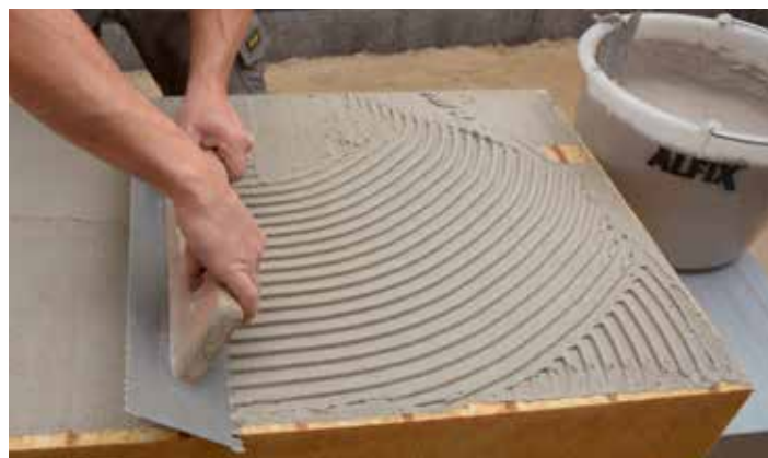
Påføring af facadeklæber med tandspartel
