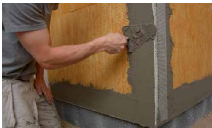
Hjørnelistens armeringsnet trykkes ind i grundpuds
