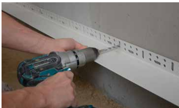
Forboring af hul til Alfix Startvinkel Flex
