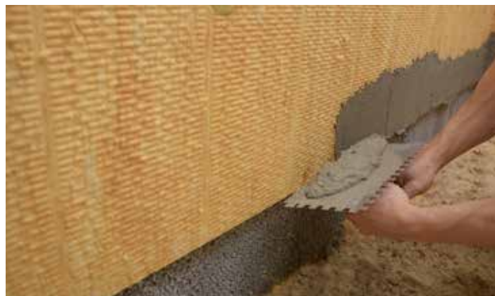
Påføring af grundpuds
