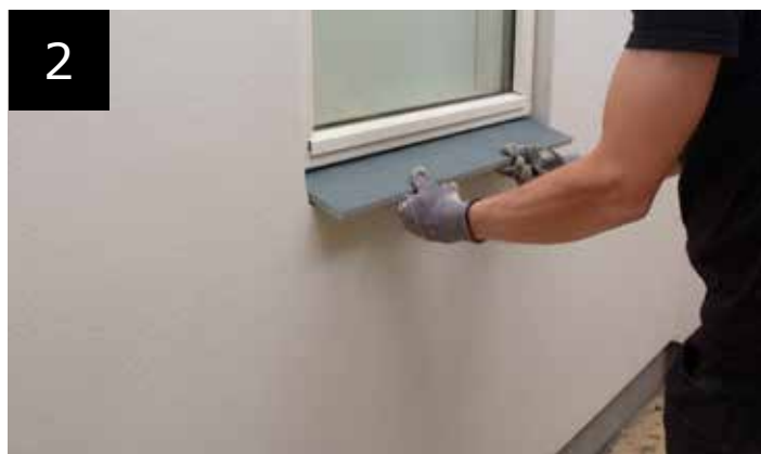
Montering af skifer-inddækning
