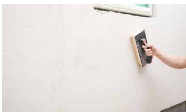
Overfladen bearbejdes med filtsbræt eller svamp
