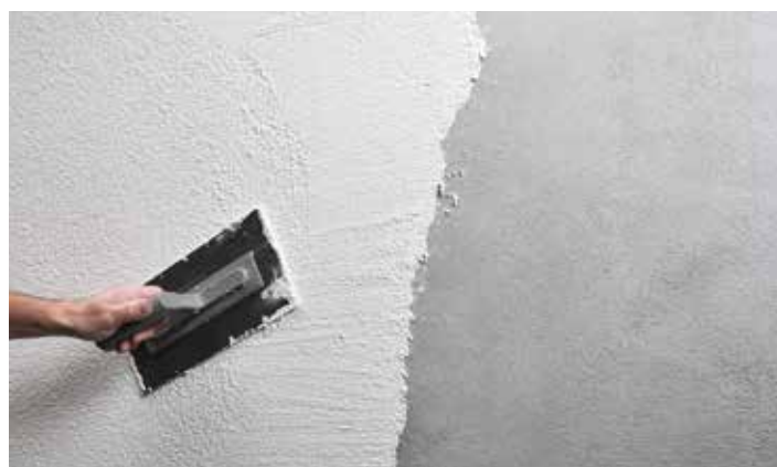
Overfladen bearbejdes med plast glittebræt
