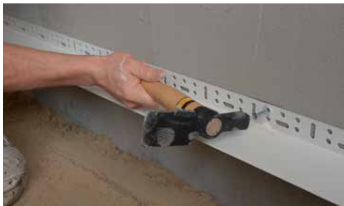
Montering af Alfix Startvinkel Flex med Alfix Slagdybel
