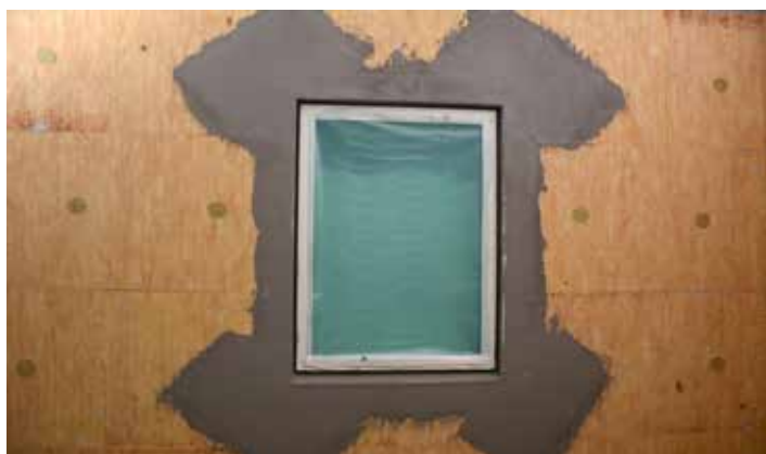
Ekstra forstærkning omkring vinduer
