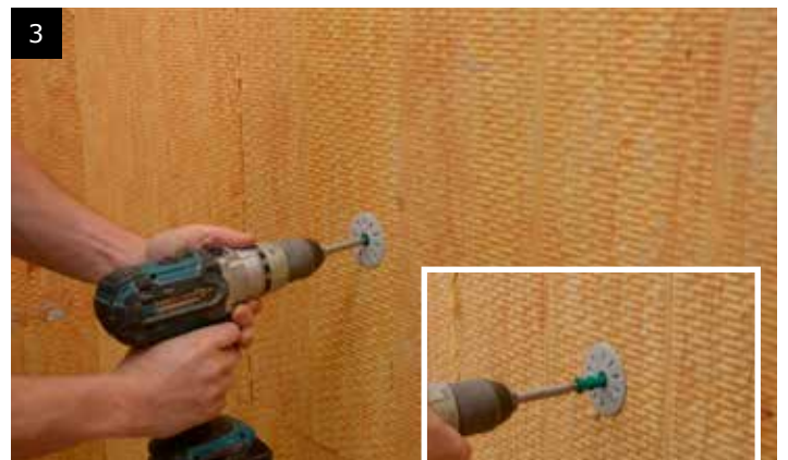
Montering af termodybel
