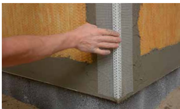
Placér hjørnelisten i den friskpåførte grundpuds
