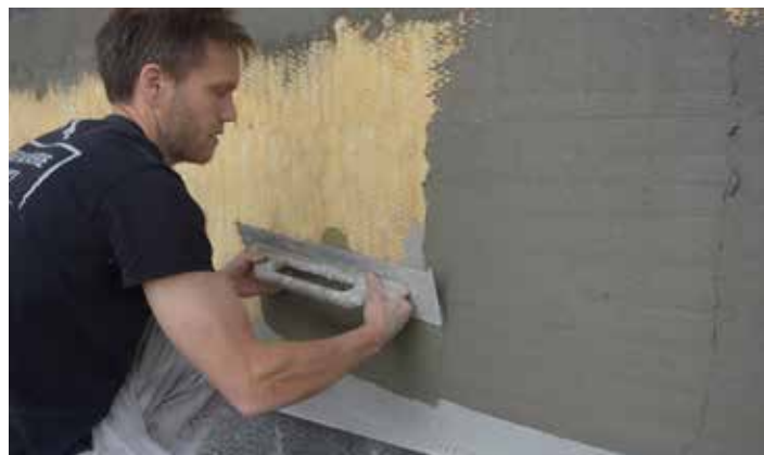
Påføring af grundpuds - Alfix DuraPuds 810
