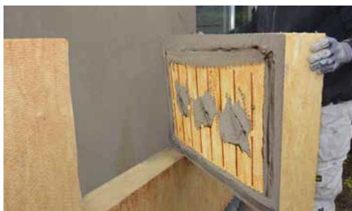
Montering på ujævnt underlag
