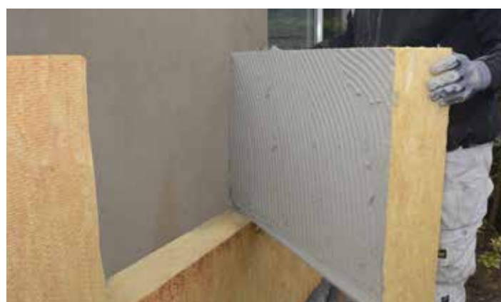
Montering på jævnt underlag
