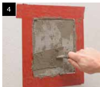
4 Grundpudslag og armeringsnet
