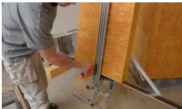
Tilskæring af isoleringsplade
