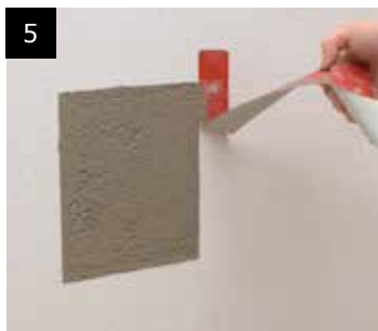
5 Afdækningstape fjernes
