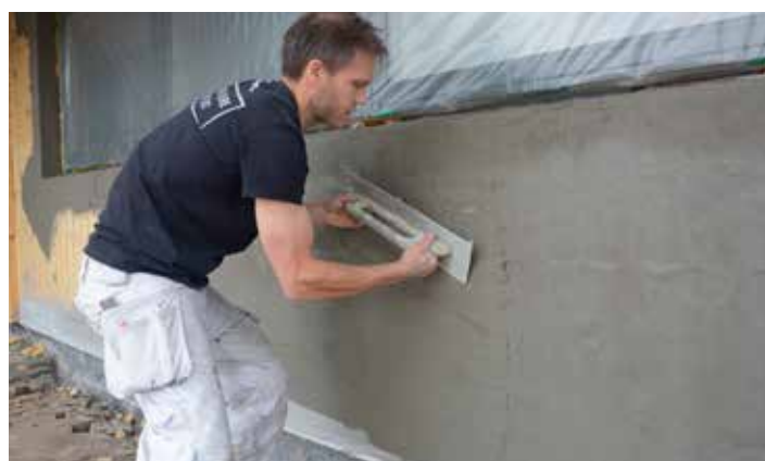
Træk grundpudsen på med stålbræt
