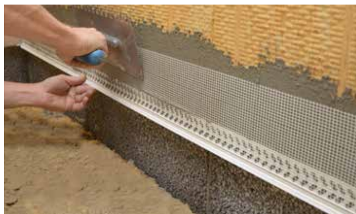
Bundlistens armeringsnet trykkes ind i grundpuds
