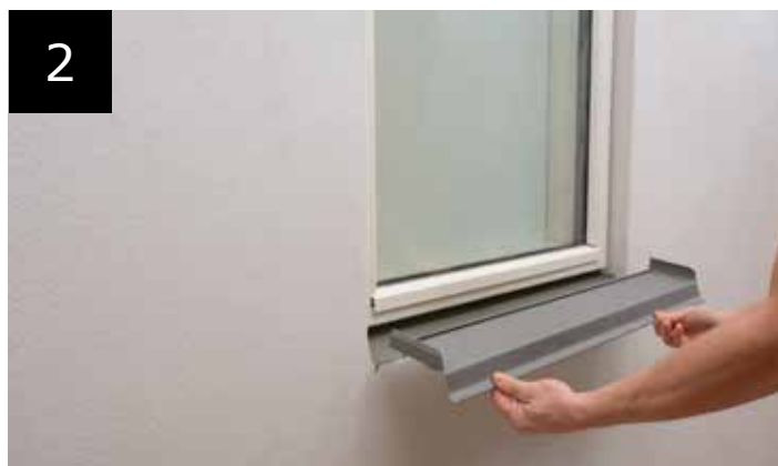
Montering af zink-inddækning
