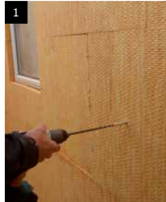
Udboring med 4-skærs murbor
