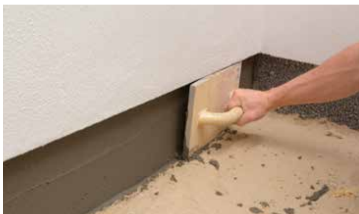
Bearbejdning med pudsebræt til jævn overflade
