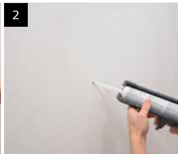
2 Ifyldning af Alfix M-Silicon
