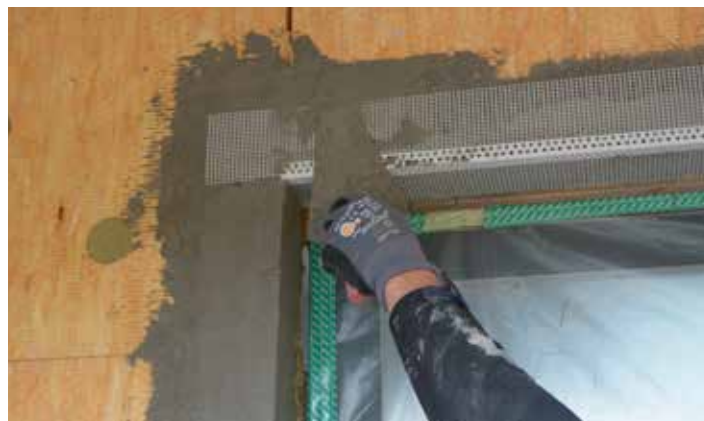
Montering af tilpasset hjørneliste i vinduesoverfals
