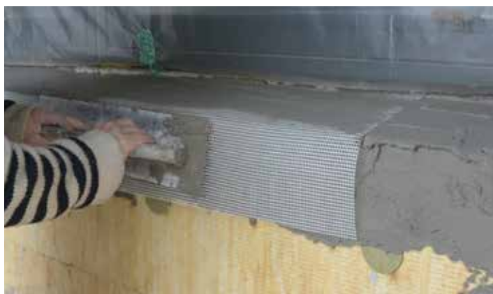
Forstærkning under vinduesfals med armeringsnet
