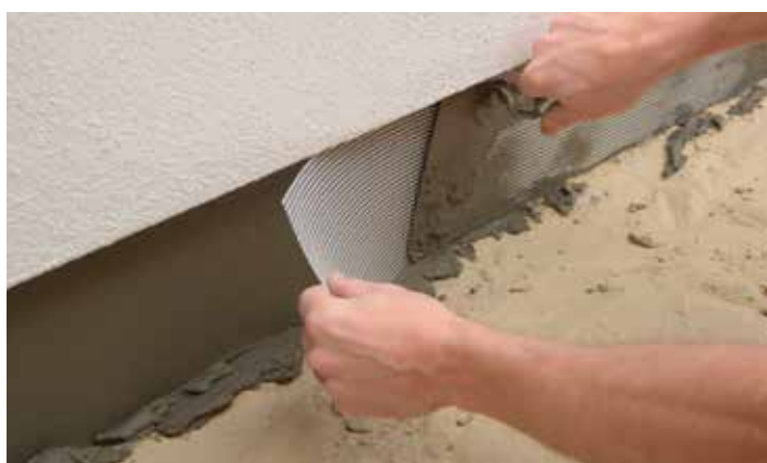
I den våde puds monteres armeringsnet
