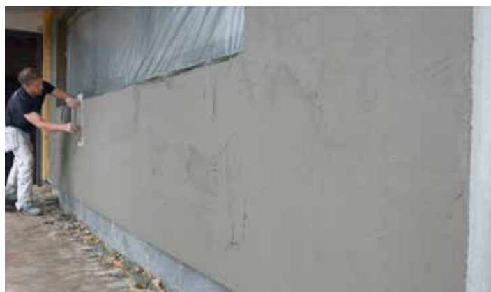
Efterglit med stålbræt
